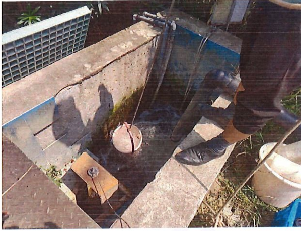
DW001（厂区总排口）（★1）
